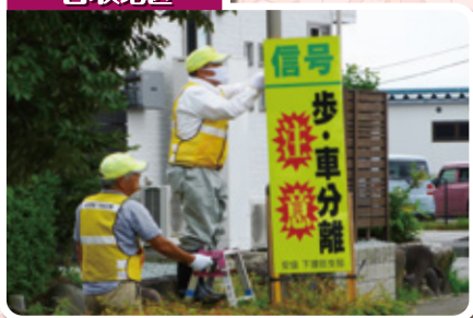
歩行者と車両の分離式信号に変更された小学校前の交差点に看板を設置し、通行車両の注意を喚起。
